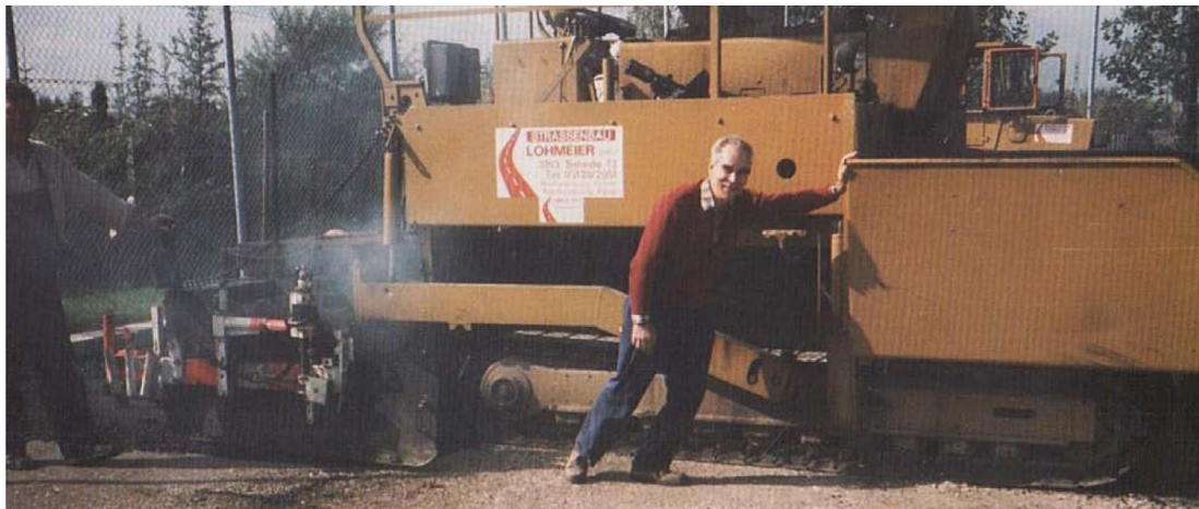
Straßenfertigungsmaschine auf der Fläche des EC Bilm e.V. im Jahr 1988
